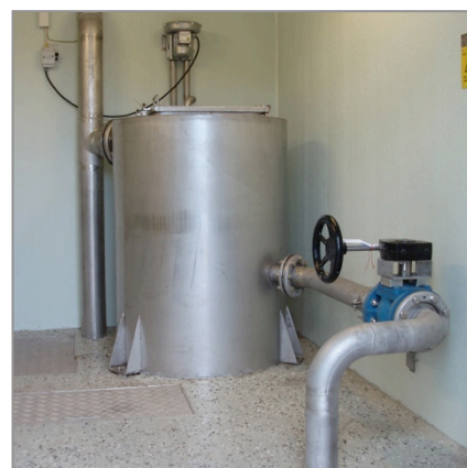
Maskinutrustning för biologisk rening.
