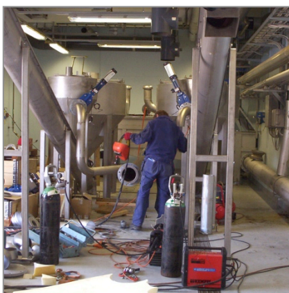
Montage och service.
